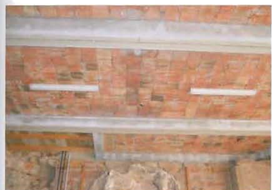
在天花板上有固定鋼筋的鉤子。根據建築圖指示，所掛裝飾物的重量並沒有超過鉤子的負荷能力。
